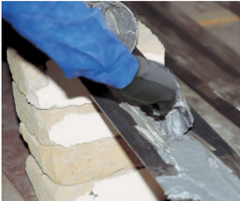
Aplicarea Adesilex PG1 pe o platbandă metalică
