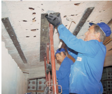
Aplicarea platbandei metalice pentru armarea structurală
