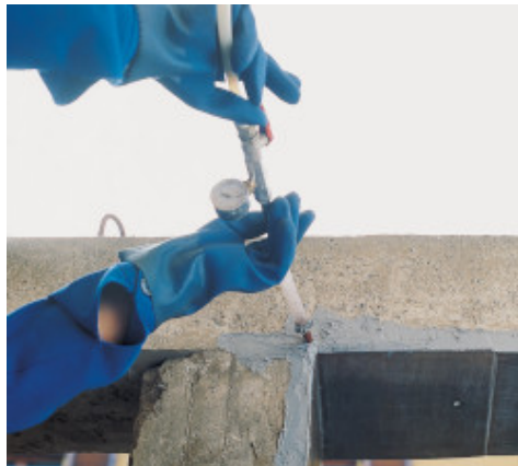
Grinda placată cu Adesilex PG1
